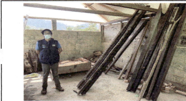
Foto 7: Ing. Marlon Javier en el lugar donde se va a realizar remozamiento.
